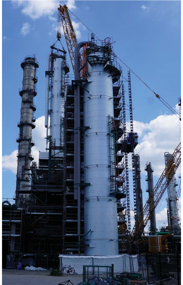
Die Kolonnen am Aufstellort.
