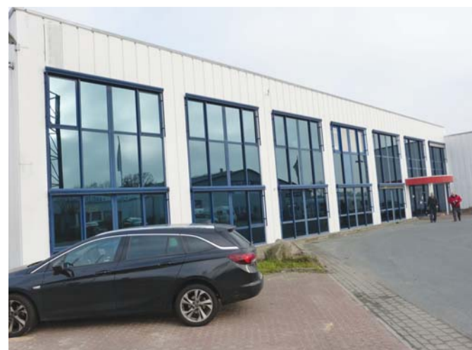
Die neue Halle in Stuhr bei Bremen von außen.
